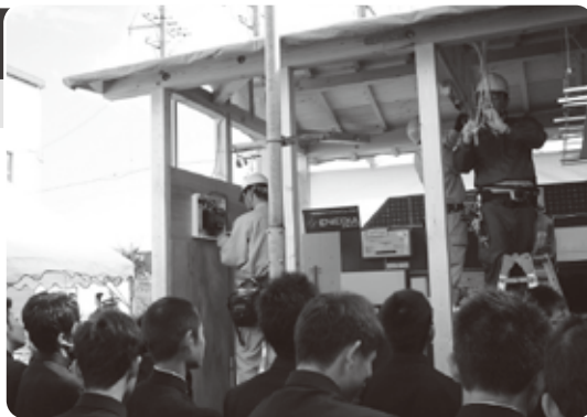
屋内配線工事を実演
